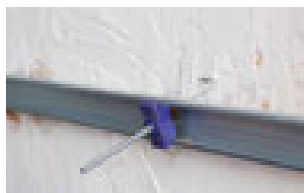
Mise en place de la tête
